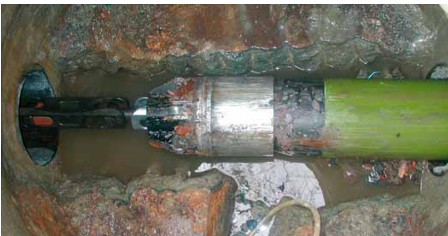
Durchfahrung eines Zwischenschachtes mit Führungshülse und anhängendem Neurohr.
