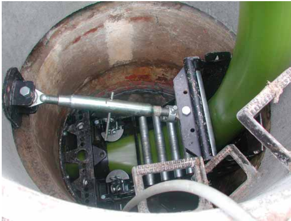
Ein Blick von oben in den Schacht.
