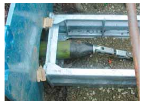
Eingezogenes Rohr in der Zielgrube
