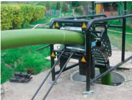
Der Rohrstrang wird mit Burstform ovalisiert und durch den Schacht in das Altrohr eingezogen.
