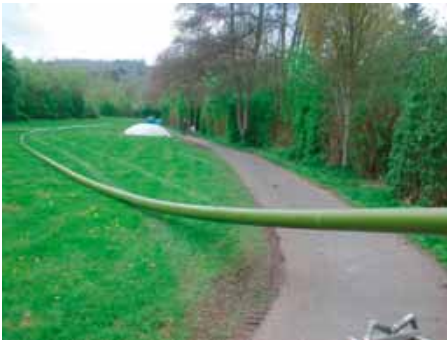
Der ausgelegte Rohrstrang kurz vor dem Einzug.
