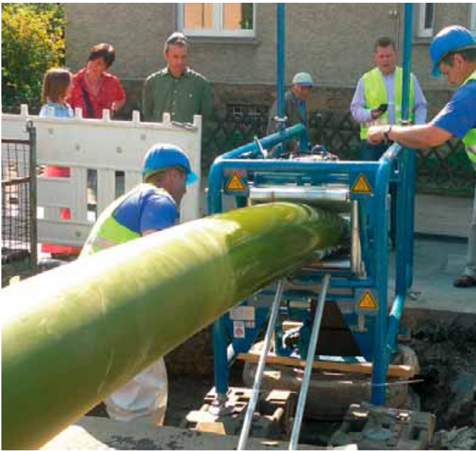
Burstform beim Rohreinzug durch Schacht.
