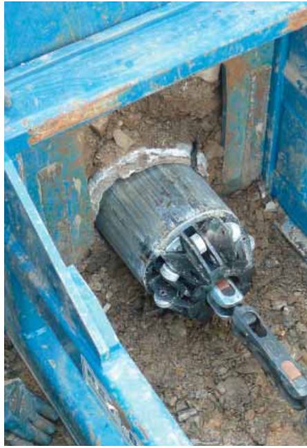
Die Führungshülse erreicht die Zielgrube und wird demontiert.
