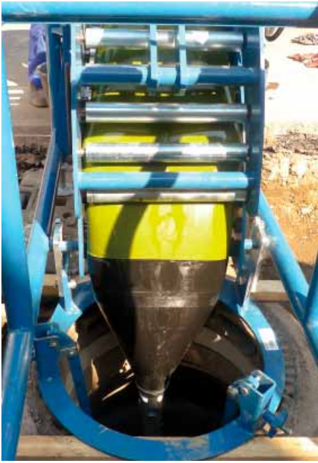
Beginn des Rohreinzugs.
