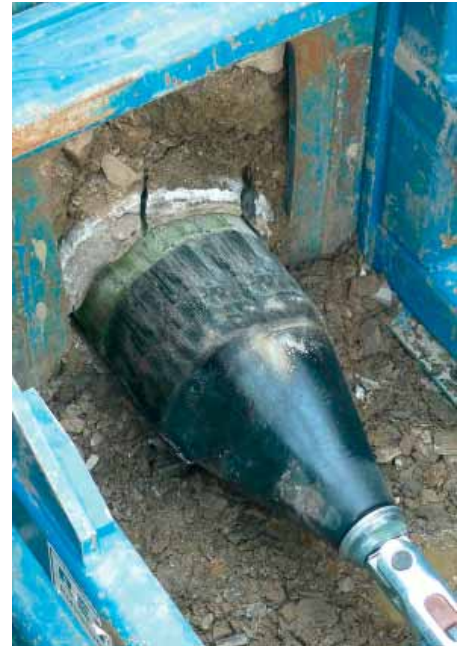
Hinter der Führungshülse folgt der Zugkopf mit dem Rohr.
