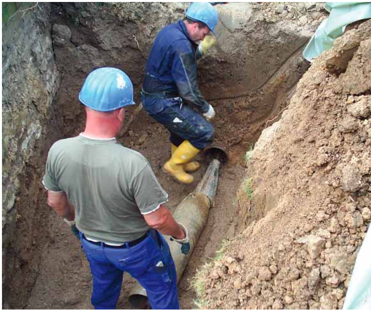
Montage des Aufweit- / Berstkörpers auf die Lafette.
