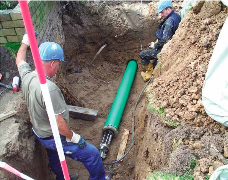
Ankoppeln eines Kurzrohrmoduls an den Rohrstrang.
