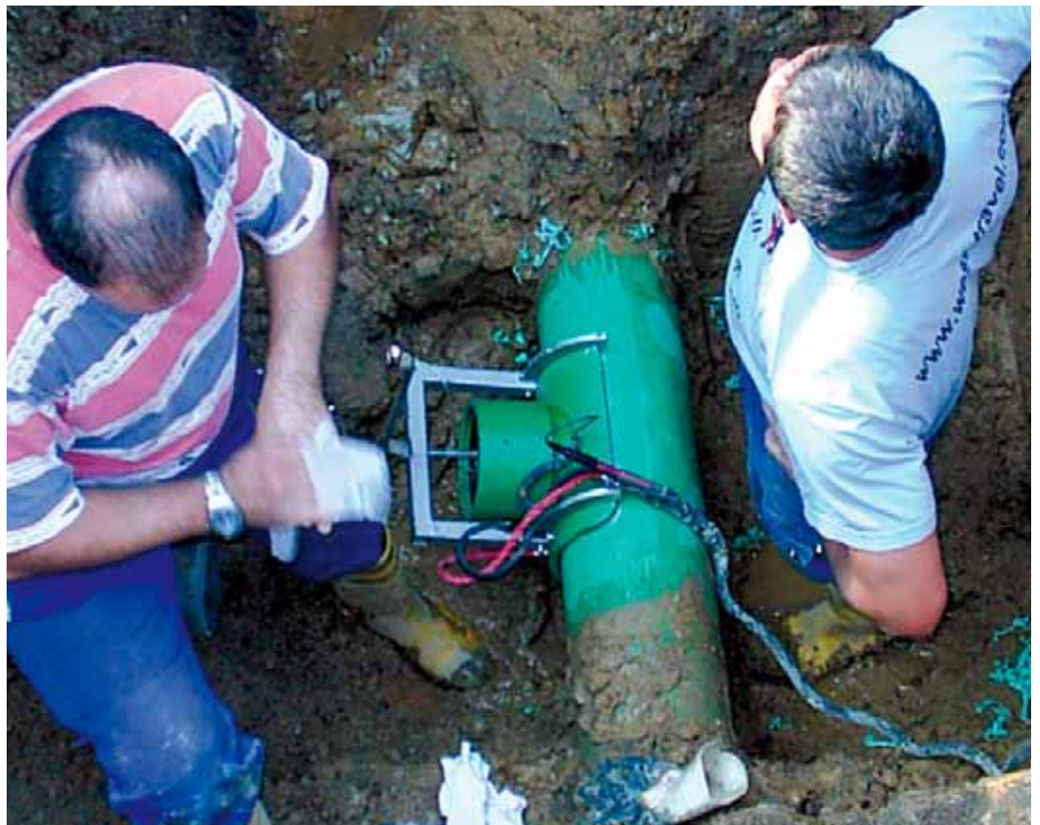
Montage des Aufschweißsattels für die Übernahme / Einbindung der Hausanschlussleitungen
