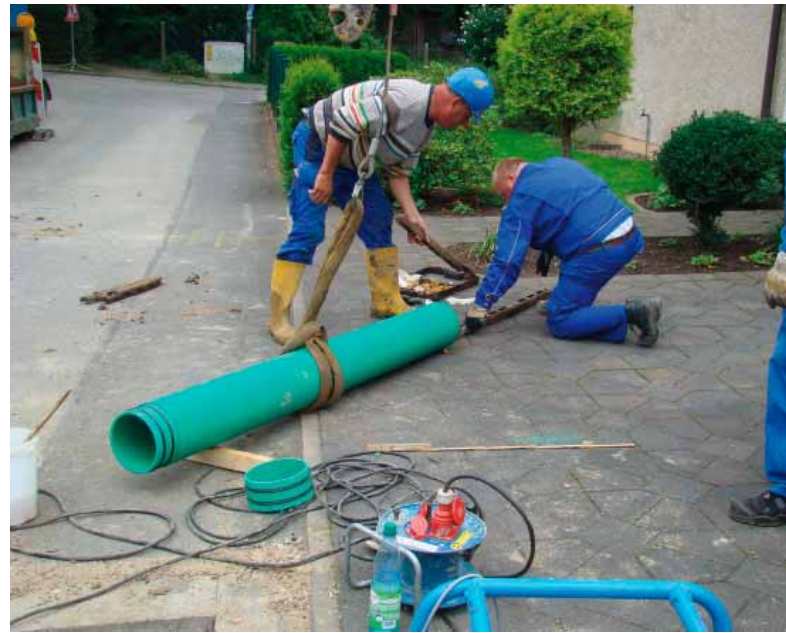
Vorbereitung eines Kurzrohrmoduls aus PP-HM für den Einbau.
