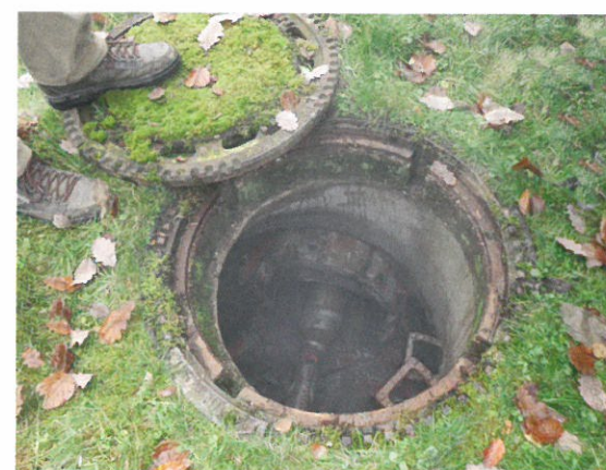
Bild oben rechts: Beginn des Berstvorganges mit Aufweitung und Neurohr.
