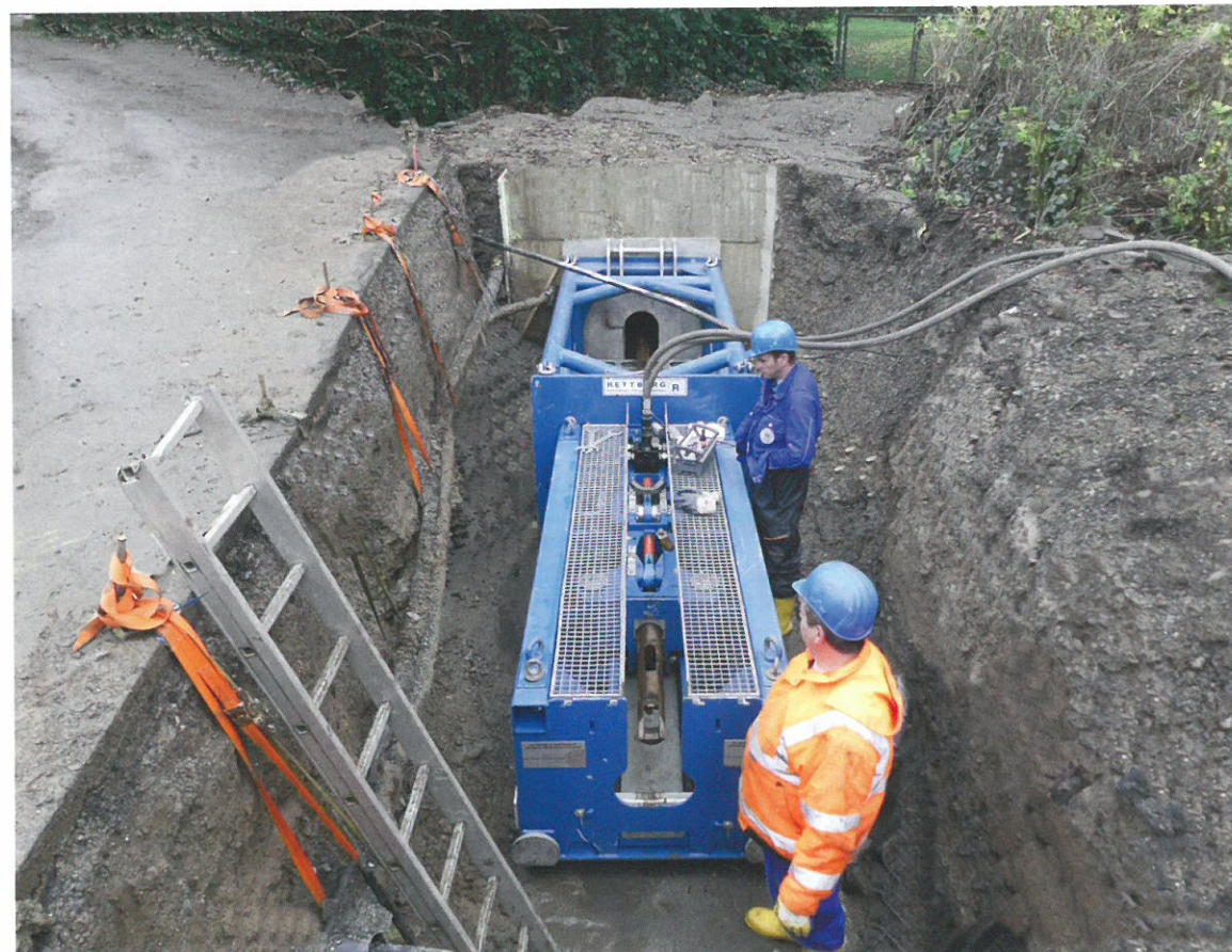
GRUNDOBURST 1900 G beim Rohreinzug.
