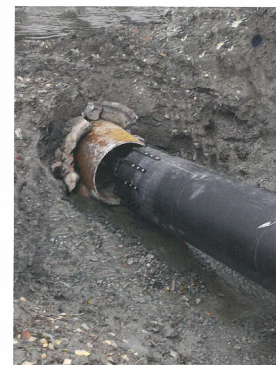
Bild oben rechts: Beginn des Berstvorganges mit Aufweitung und Neurohr.
