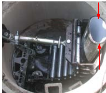
Ovale Verformung des PE-Rohres kurz vor dem Einzug in das Altrohr.
