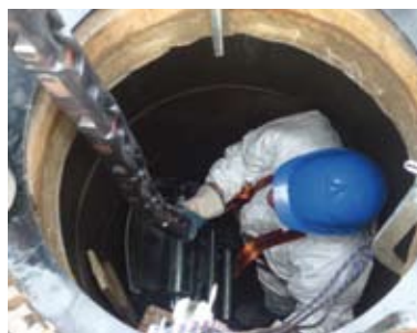
Kurzgestänge kann an das normale QuickLock-Gestänge angebunden werden und ist ebenfalls schub- und zugstabil.
