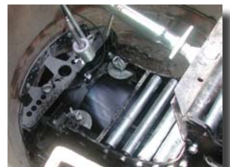
Durch den Verformungsprozess werden eine höhere Kurvengängigkeit und leichtere Handhabung erreicht. Die Materialstrukturen bleiben dabei erhalten. Eine Überdehnung des Grundmaterials wird ausgeschlossen. Das Foto oben zeigt den Rückverformungsprozess im Schacht kurz vor dem Einzug in das Altrohr.
