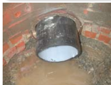
Verlegung Tight in pipe.
