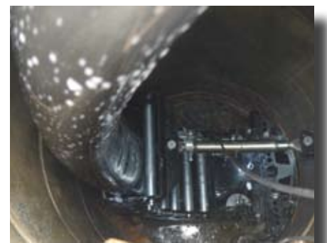
Blick in den Abwasserschacht mit der Einfädung in das Altrohr.
