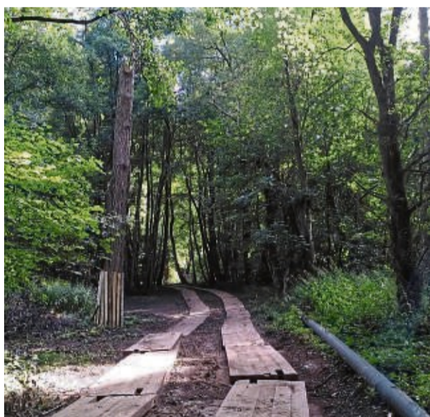
Baggermatratzen: Die Arbeitsfahrzeuge fahren über Holzbohlen, damit sie den Boden nicht beschädigen.
