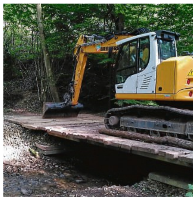
Über die Schede führen zwei Brücken. So muss das Wasser nicht umgeleitet werden.
