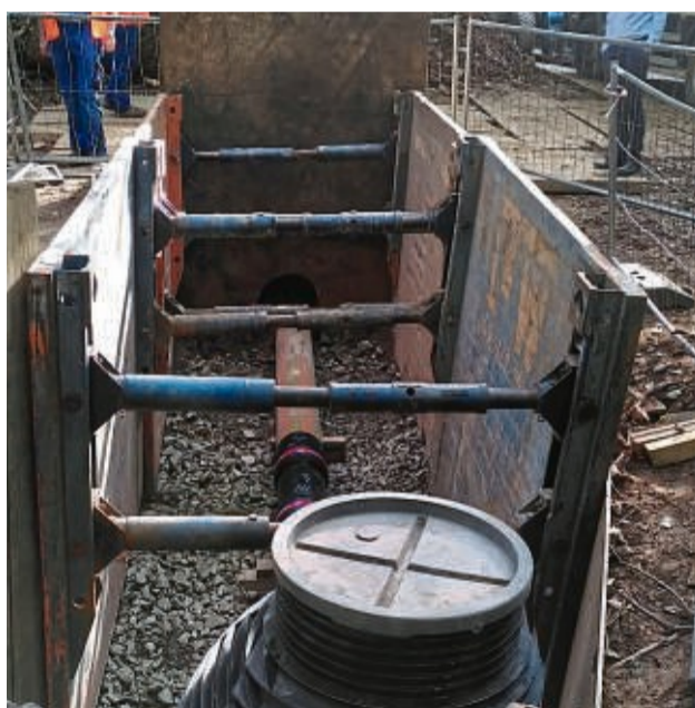
Nur die Kontrollschächte werden ausgebagert, nicht die gesamte Länge der Leitung.
