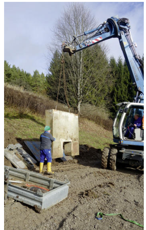
Betonwiderlager | Fotos: Isas GmbH
