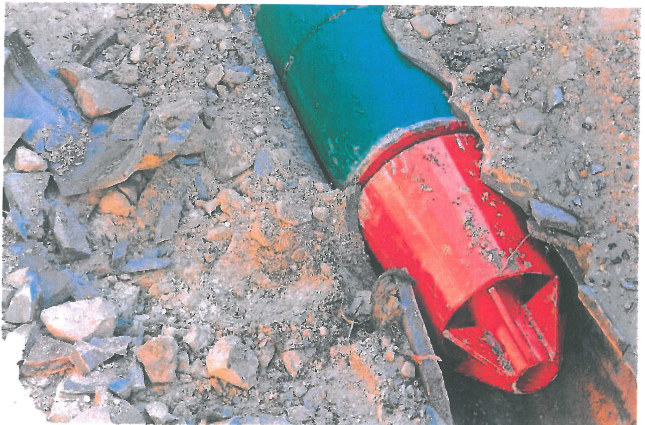
Neuer am anderen Ende ankommender Rohrstrang
