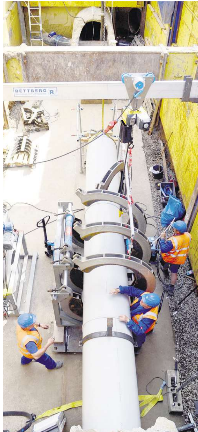
Experten bringen die Rohre in Position.
